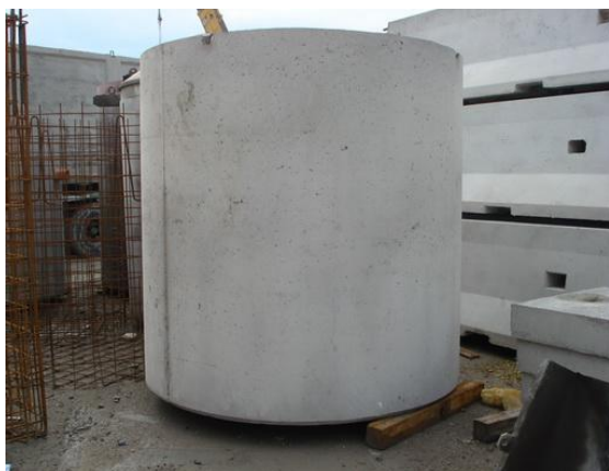
Filtro percolatore in fase di allestimento
