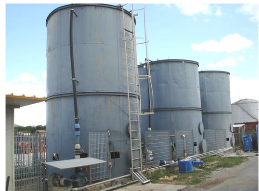
Filtri percolatori a servizio della lavanderia Lava +
