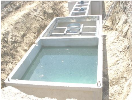
Depuratore chimico- fisico in corso di installazione
