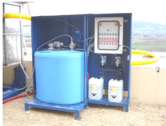
Stazione di dosaggio degli additivi chimici
