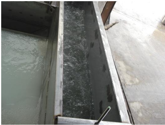
Comparto di correzione del pH e coagulazione primaria
