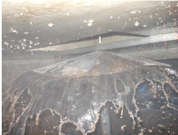
Distributore di flusso "splash-plate"
